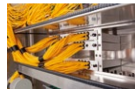
LGX module with splitter LGX модуль со сплиттером
